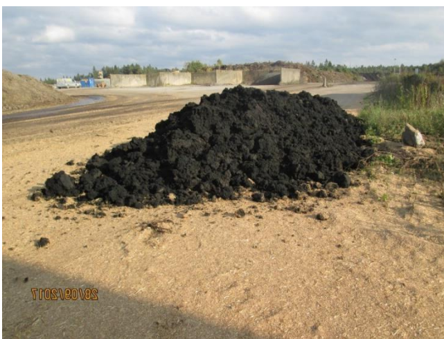
Figur 16. Avloppsslammet levererades i containerflak och tippades vid sidan av flis/halmhögen och blandades med skopa.
